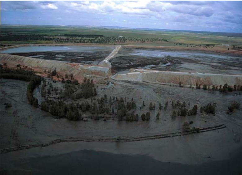
Ruptura del dique de colas de la mina de plomo y zinc Los Frailes, Aznalcóllar, España.
