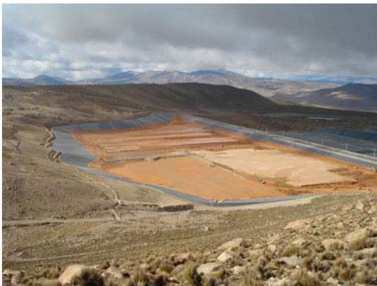
Las geomembranas evitan que líquidos y residuos tóxicos afecten el suelo y las napas de agua.
