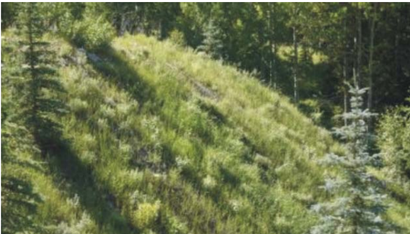
Ejemplo de restauración. Estabilización de talud mediante cobertura vegetal. Hope Mine, Colorado, Estados Unidos.
