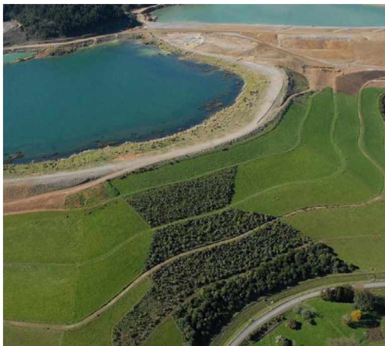
Estabilización de talud y cobertura vegetal en una antigua mina.
