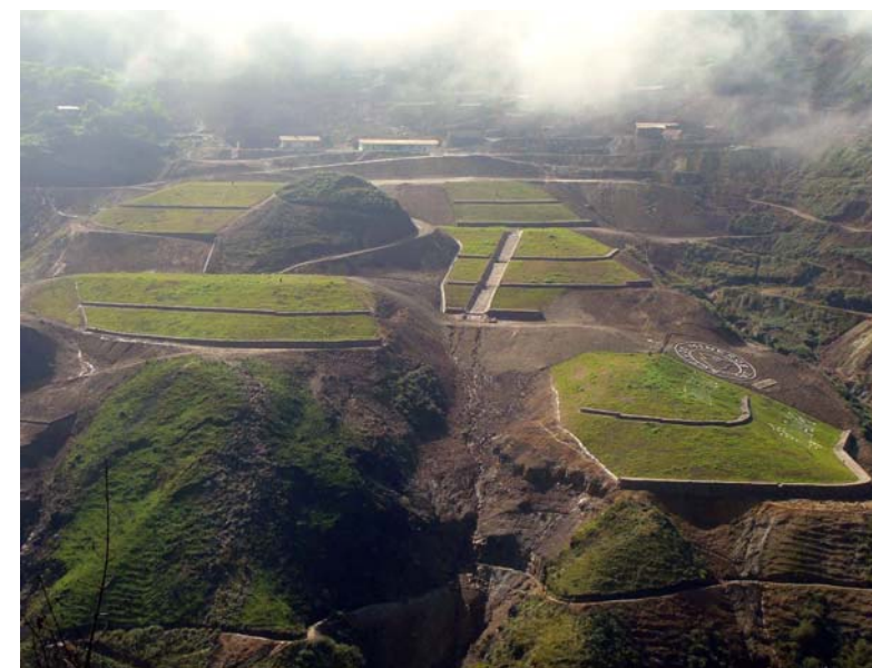
Obras de estabilización, revegetación y drenaje, en antiguos diques de colas.
